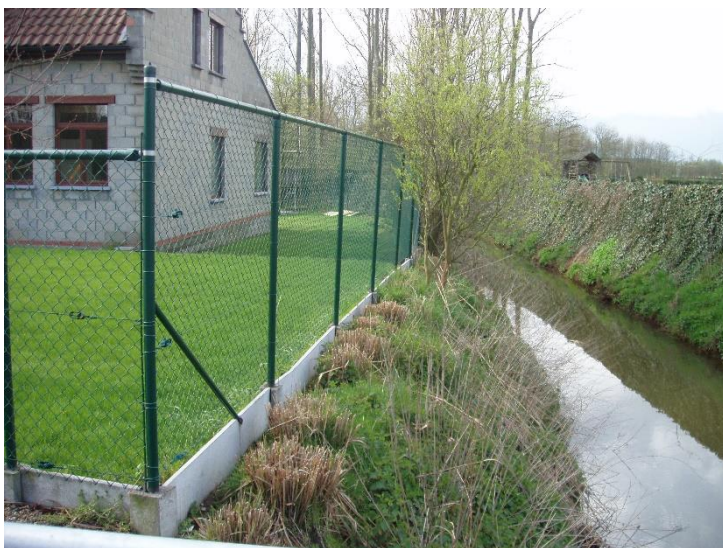
Figuur 11: Voorbeeld van illegale constructie binnen de 5-meterzone
