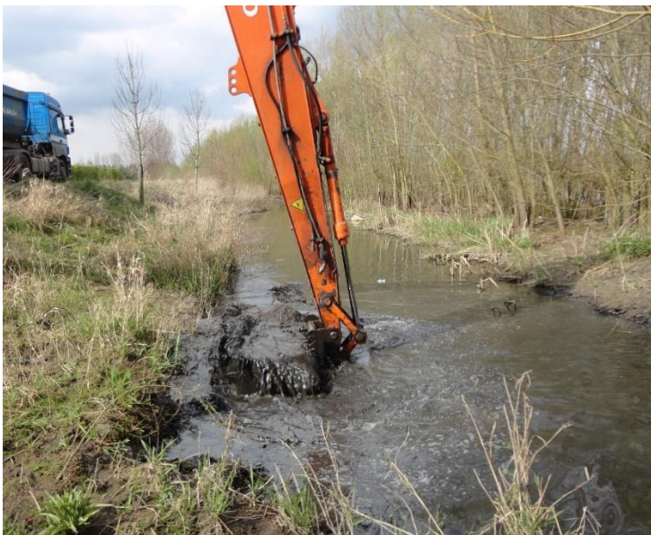
Figuur 9: Slibruiming van een zandvang
